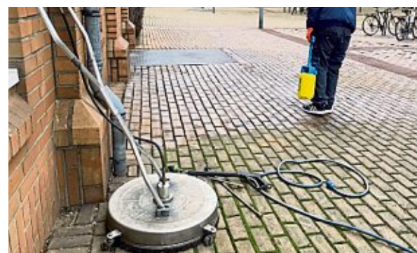
Hier wird Lösungsmittel auf die Steine gesprüht.
